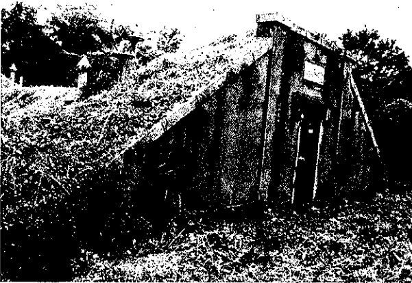
③水道山配水池
